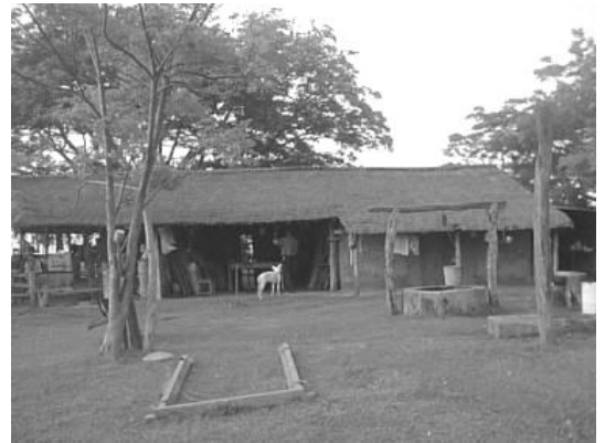
Una de las casas de la colonia Nueva Valencia en 1012.
