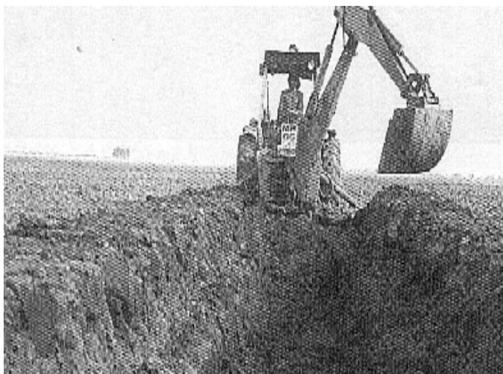
**Figura 8.** Construcción de canal para riego que servirá también como desagüe.
