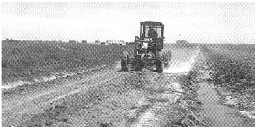
**Figura 6.** Mantenimiento de camino de chacra con motoniveladora. Se observa la cuneta profunda hacia la chacra.
