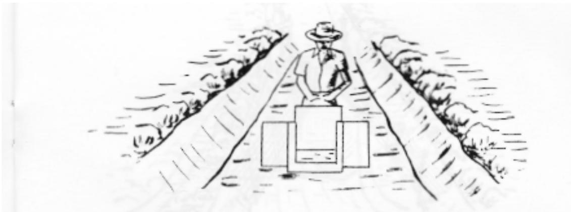
4. Coloque la lámina de la compuerta en las guías, para evitar que estas se descuadren al ser instaladas y la lámina se desplace fácilmente. **(Figura 5)**
