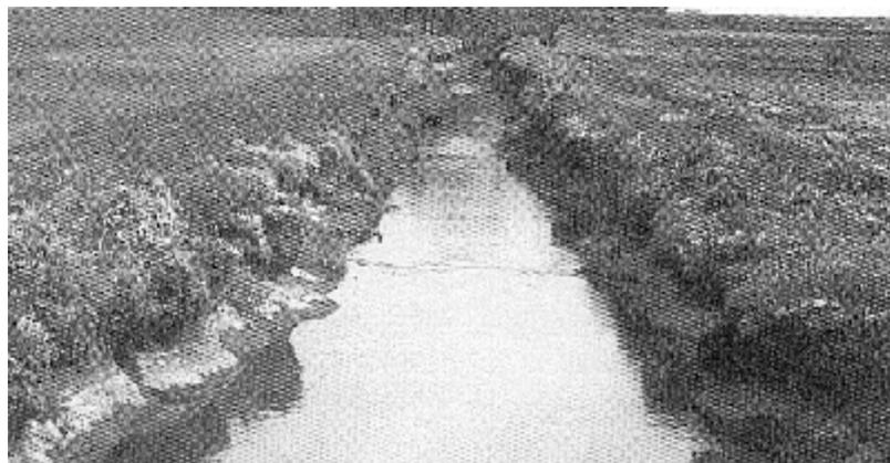
**Figura 7.** Desagüe principal. En este caso se trata de una cañada natural que se mantiene limpia.
