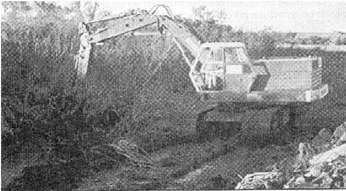
**Figura 9.** Limpieza del desagüe Principal con excavadora.
