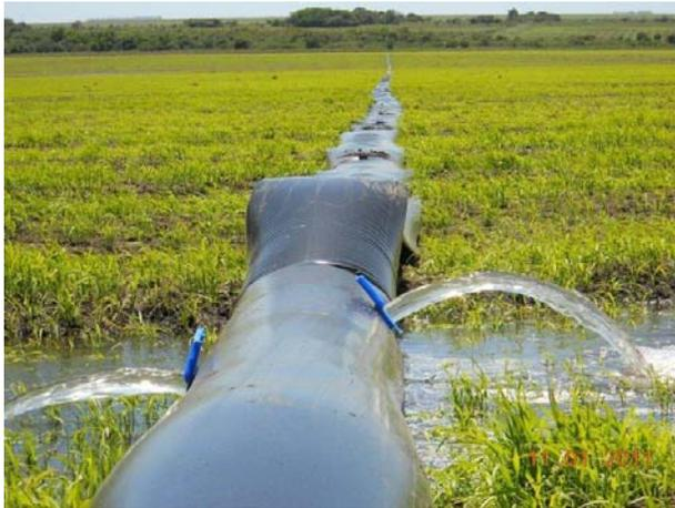
sustituyendo las conducciones tradicionales de tierra con mangas de polietileno. Para ello, se colocaron mangas a una pendiente máxima y a una distancia entre ellas de 1,60 metros.
